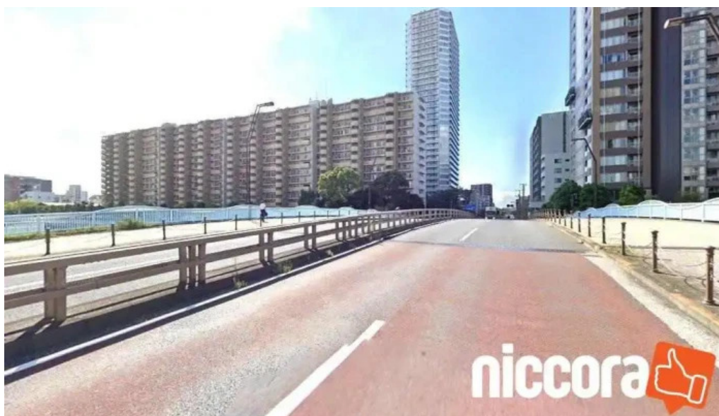
(株)日本システムテクノロジー 江東区
