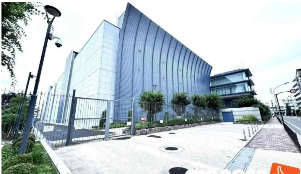
Nttデータ 三鷹データセンターeast 三鷹市
