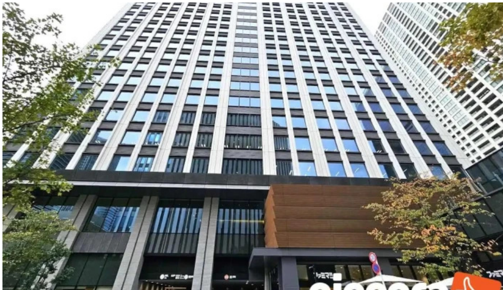
神谷町トラストタワー 港区
