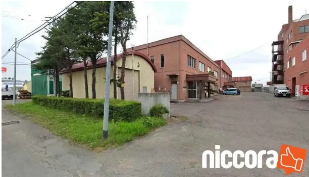
(株)ズコーシャ データセンター 帯広市
