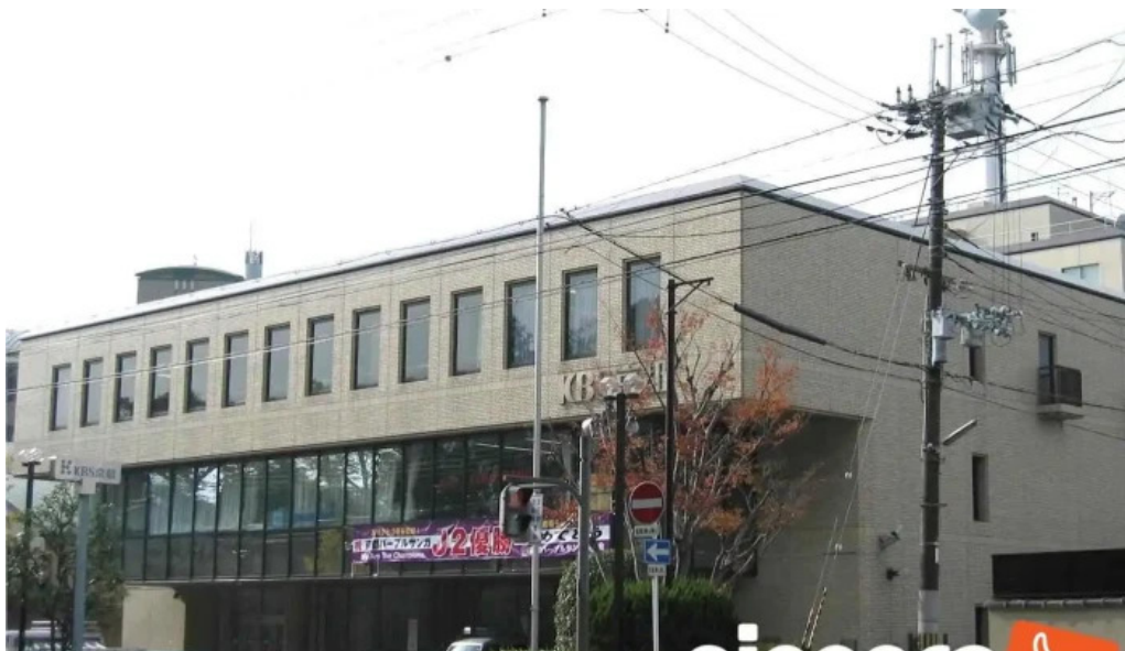
iccコンサルタンツ 京都サテライトオフィス icc consultants kyoto 京都市
